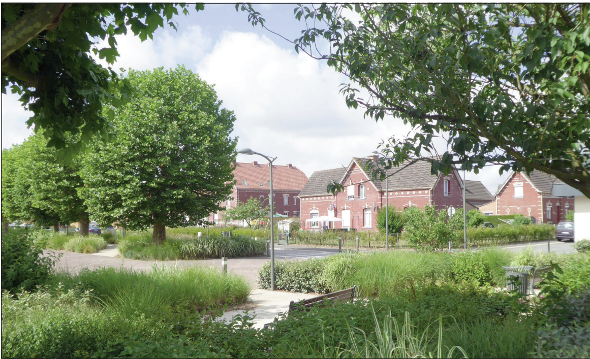
Les sols artificialisés ont été diminués de 18%, réduisant les enrobés au strict nécessaire.
