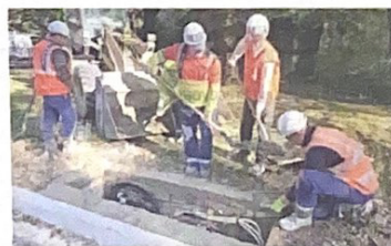
Les ouvriers réalisent plusieurs chantiers simultanément.
