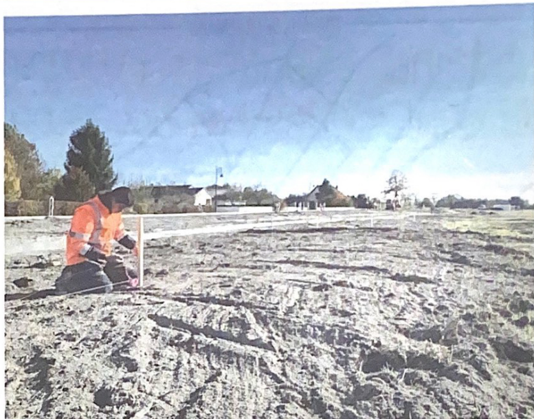
Les agents d'Edivert procèdent actuellement aux travaux en différentes phases sur la frange végétale et le futur parc des Lattitudes.
