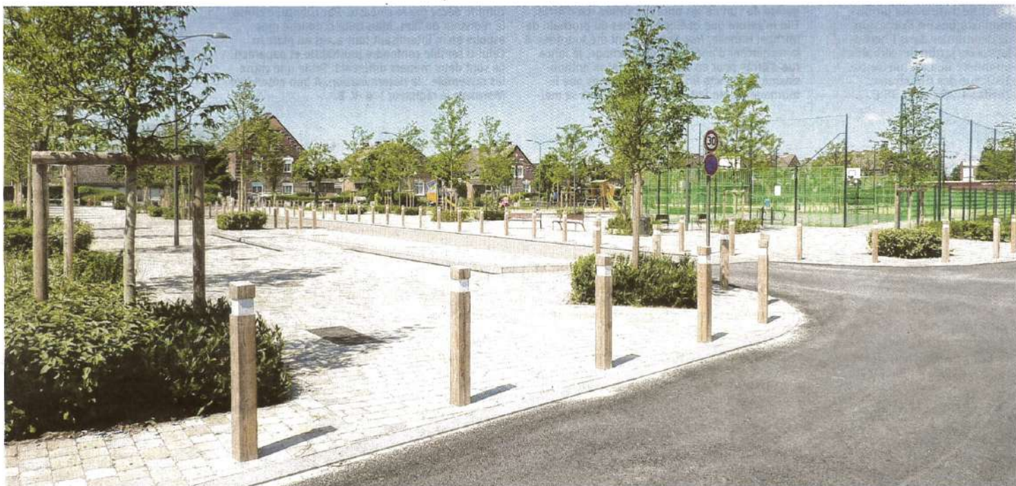
D'importants travaux ont été réalisés, notamment dans le secteur des cités Lemay et Saint-Marie.
