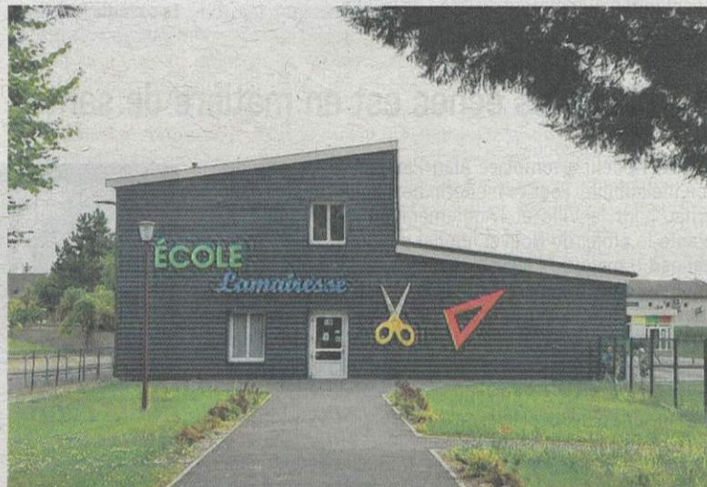
Le groupe scolaire Lamairesse, construit dans les années 70, a bénéficié d'une rénovation énergétique d'ampleur. Le bâtiment a été isolé par l'extérieur, ses combles et son plancher revus, et une centrale de traitement de l'air et du caisson adiabatique a été installée. Une nouvelle enseigne vient égayer l'ensemble.
